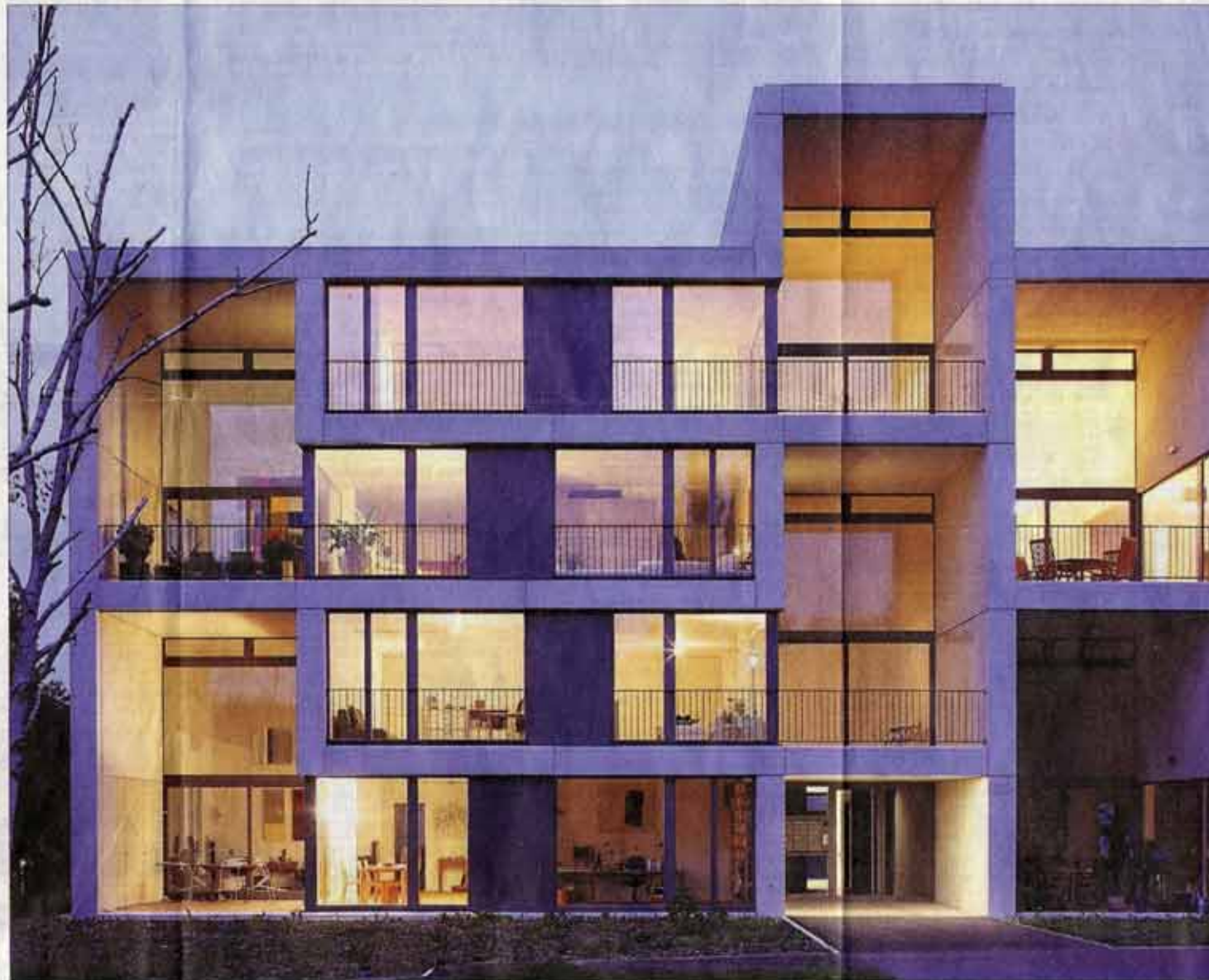
Hoch gestapelt: Das Pile Up-Gebäude in Rheinfelden bietet hohe Räume und viel Licht.
